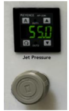
그림 3-4: 유체 압력 게이지 및 레귤레이터
