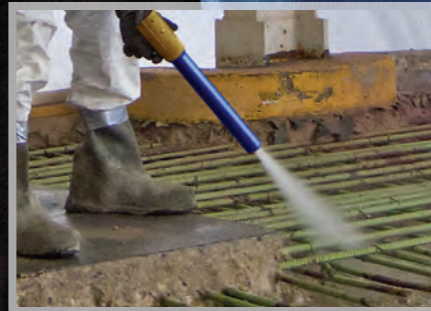
Reparación y restauración de hormigón
