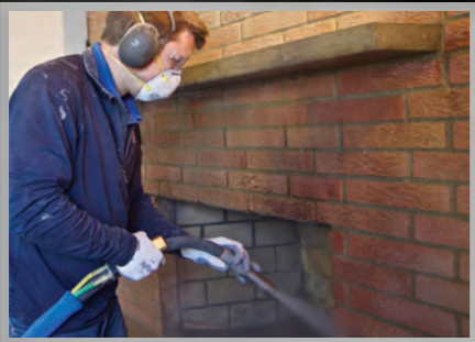
Limpieza de madera y ladrillos
