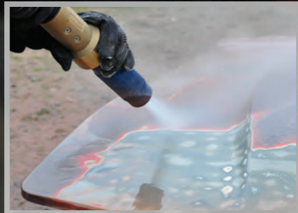
Eliminación de recubrimientos y pintura
