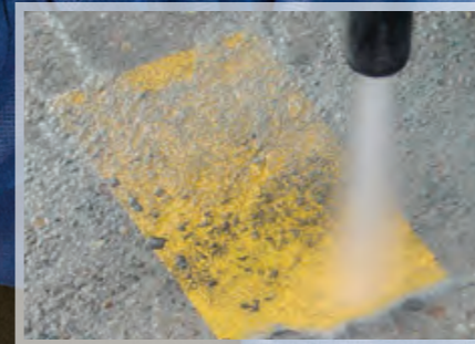
Limpieza de hormigón y preparación de superficies
