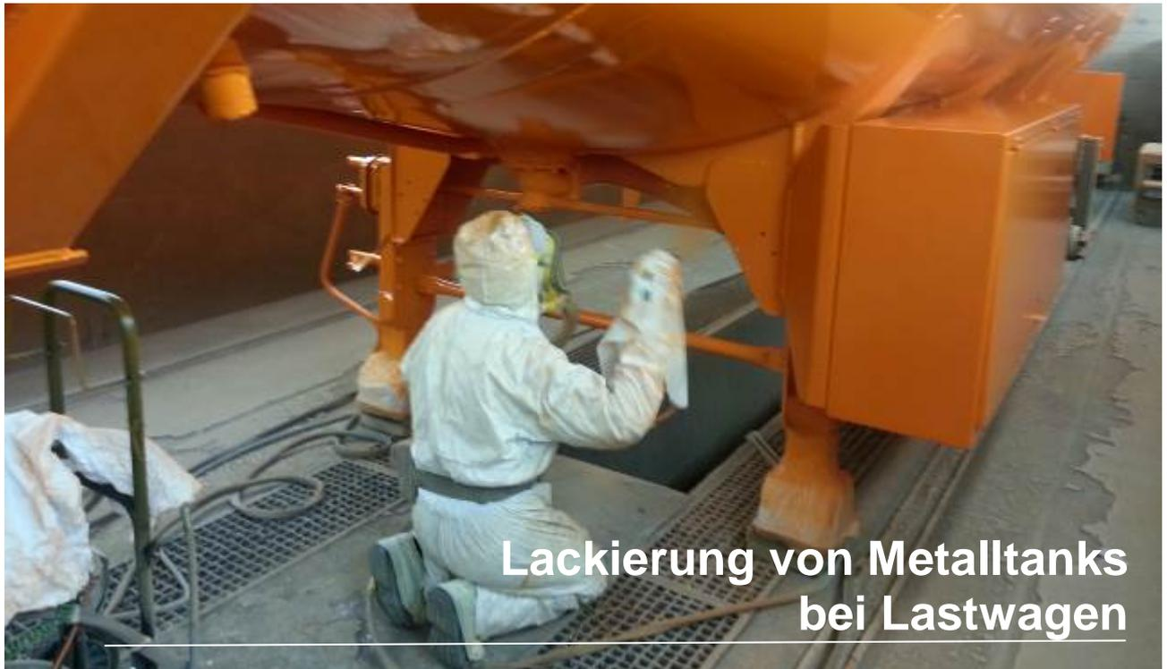
Bei Cisternas Cobo handelt es sich um eine Firma in Nordspanien, die verschiedene Arten von Metalltanks für Lastwagen herstellt. Das Lackieren dieser großen Metalltanks findet in speziell angefertigten Kabinen statt. Für die Lackierung werden konventionelle luftzerstäubende Pistolen verwendet. Diese verursachen jedoch Farbnebel und Lackverschwendung.
