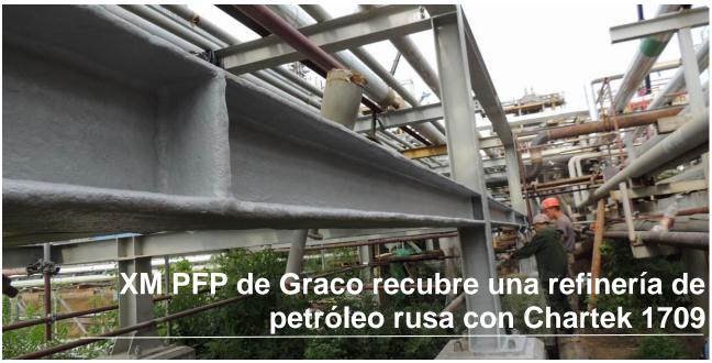
Aplicación del material intumescente Chartek 1709 en las estructuras de refuerzo de tuberías de la refinería de petróleo de Jabárovsk
