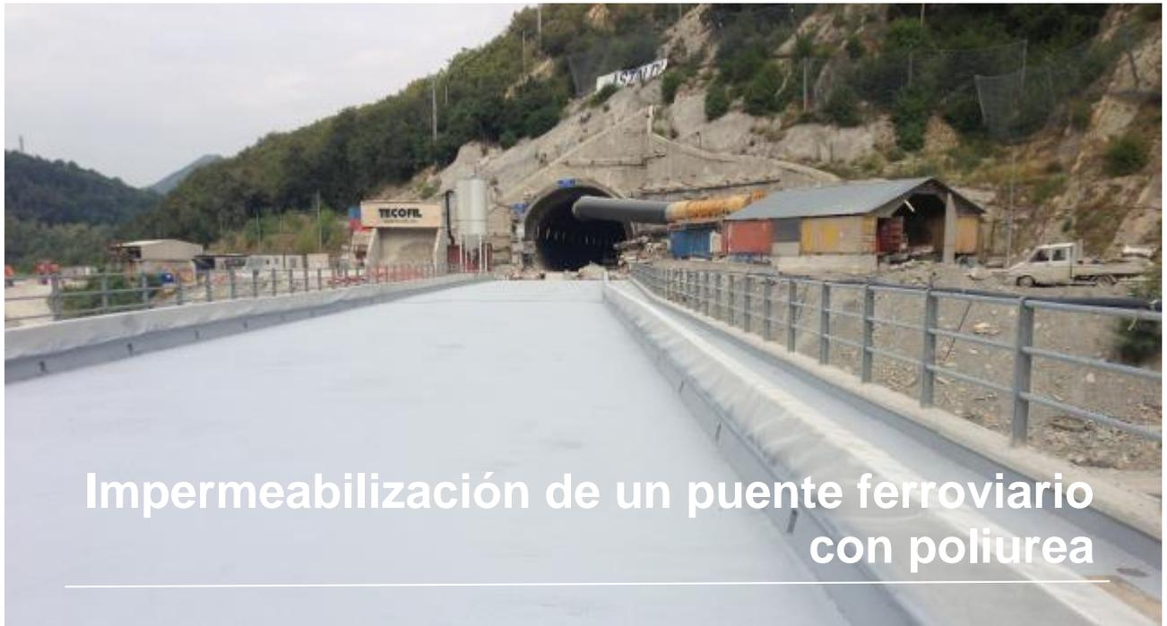
En esta historia, describimos la transformación de un puente de hormigón utilizado por el ferrocarril, que debía ser revestido con más de 6000 m<sup>2</sup> de poliurea. El puente presentaba algunos defectos y deterioros generales, consecuencia de estar expuesto a los elementos durante más de 50 años. Debido a esto, había grietas e infiltración de agua en algunas zonas.
