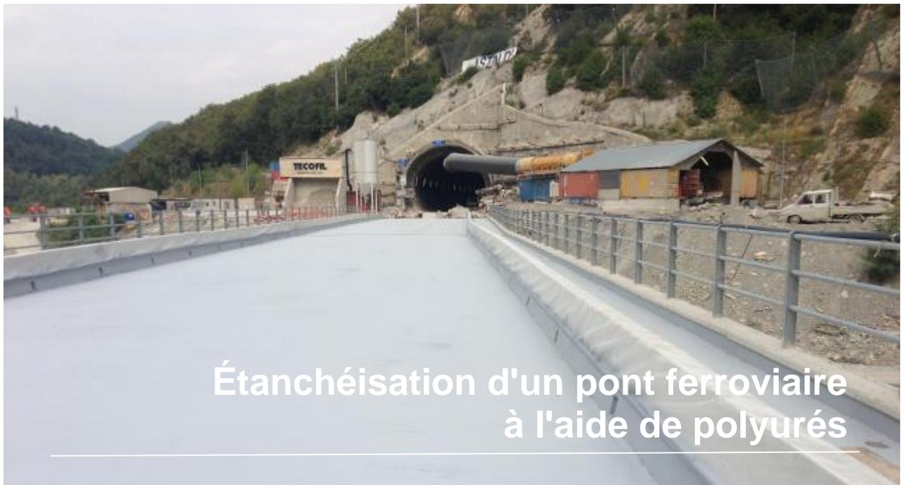
Dans cette histoire, nous décrivons la transformation d'un pont ferroviaire en béton devant être enduit d'une couche de plus de 6 000 m<sup>2</sup> de polyurés. Le pont comportait plusieurs dommages et des lésions générales dues à une exposition pendant plus de 50 ans aux intempéries avec pour conséquence la formation de crevasses et d'infiltrations d'eau dans certaines zones.
