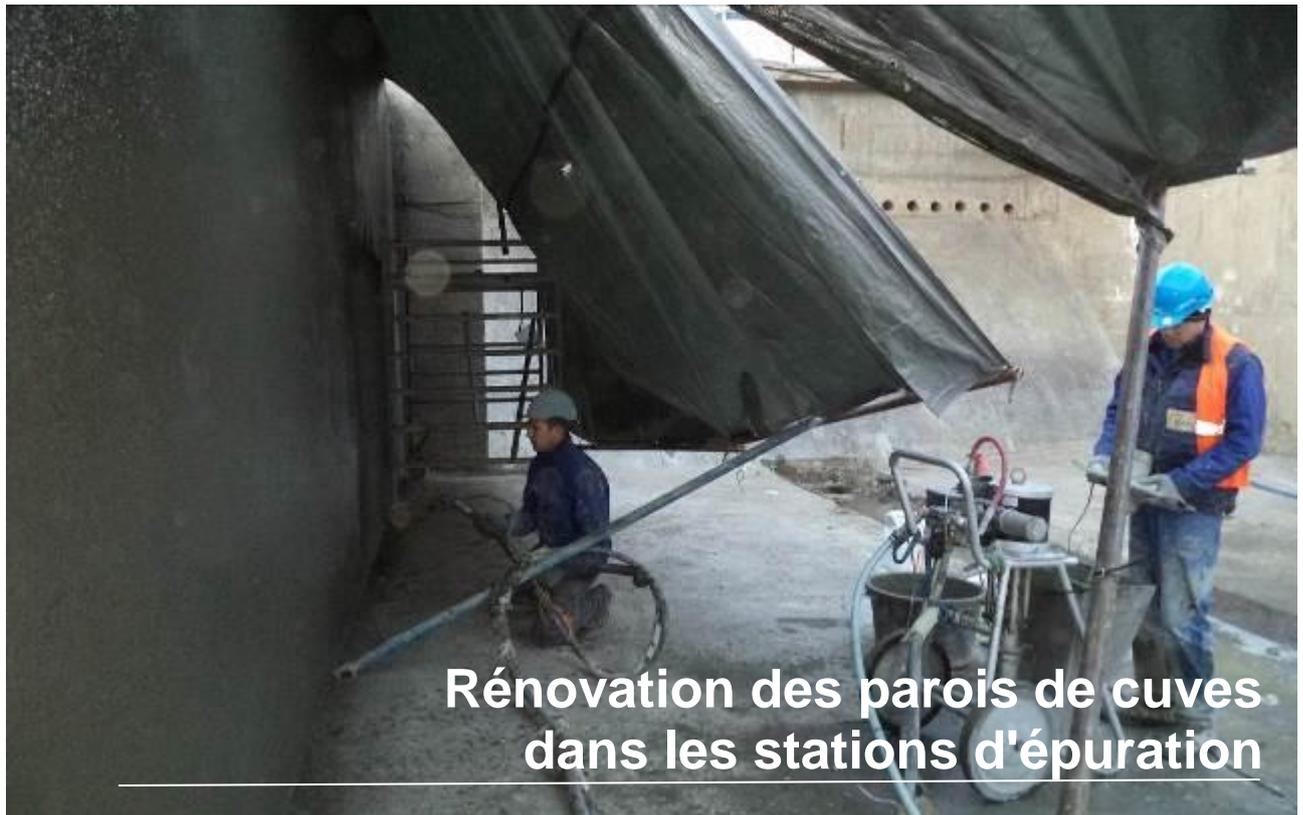
Un entrepreneur a été chargé de rénover les cuves secondaires de la station d'épuration de Tomaszów Mazowiecki, en Pologne. Le béton et la protection de sa surface nécessitaient d'être rénovés suite à leur détérioration par les eaux usées. La surface à rénover atteignait 2 000 m<sup>2</sup> et les travaux ont été effectués en trois phases.
