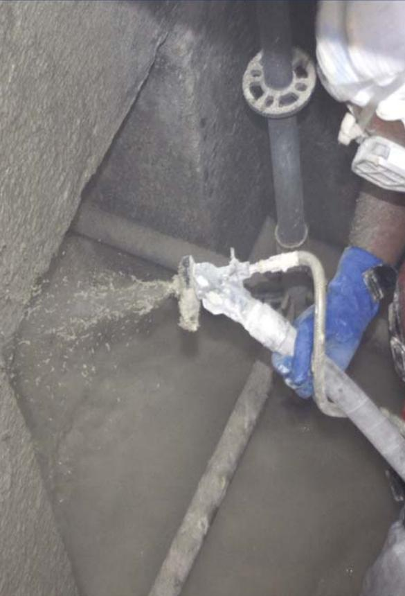
La bomba de mortero M680™ de Graco soporta materiales abrasivos como los morteros epoxi, recubrimientos antideslizantes o materiales cementosos, y emplea polímeros complejos con rellenos de bolas de vidrio, sílice o arena.
