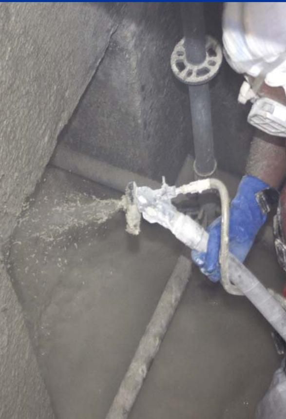
La pompe à mortier Graco M680™ supporte les produits abrasifs tels que les mortiers époxydiques, les revêtements antidérapants ou les matériaux cimentaires, et s'attaque aux polymères difficiles avec des produits de garnissage comme des écailles de fibre de verre, de la silice ou du sable.
