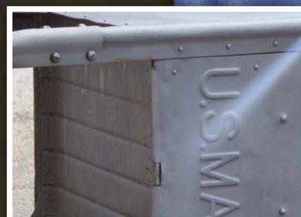
Preparación de superficies de acero
