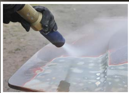
Retirada de recubrimiento y pintura
