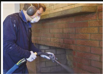
Limpieza de madera y ladrillos
