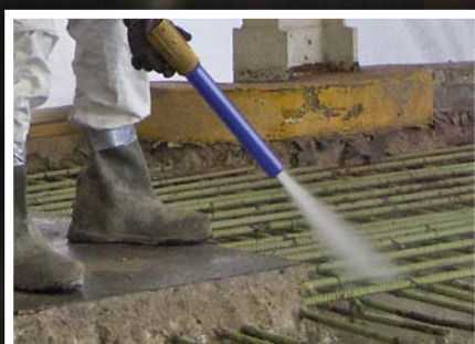
Herstelling en restauratie van beton
