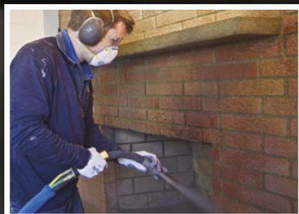
Reiniging van hout en bakstenen
