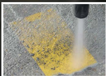
Rengjøring og overflatebehandling av betong
