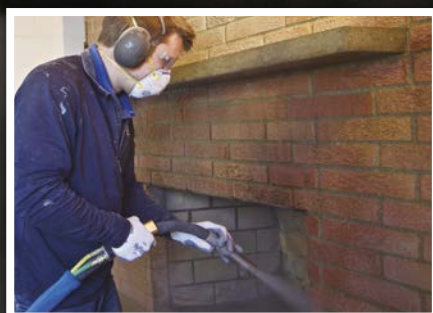
Rengjøring av tre og murstein
