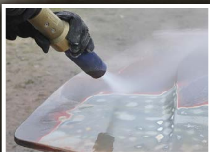
Usuwanie powłok i farb
