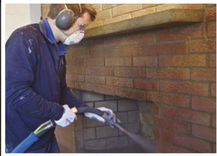
Ahşap ve Tuğla Temizleme
