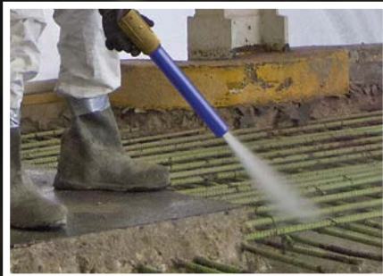
Beton Onarımı ve Restorasyon
