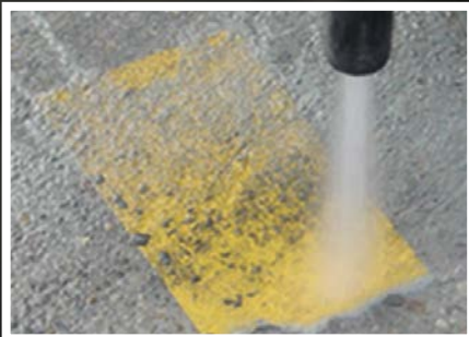
Beton Temizleme ve Yüzey Hazırlığı
