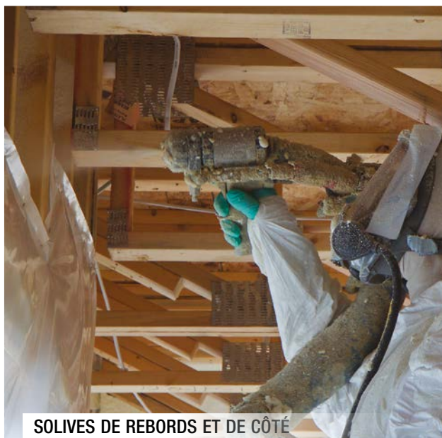
ISOLATION DES TOITURES
