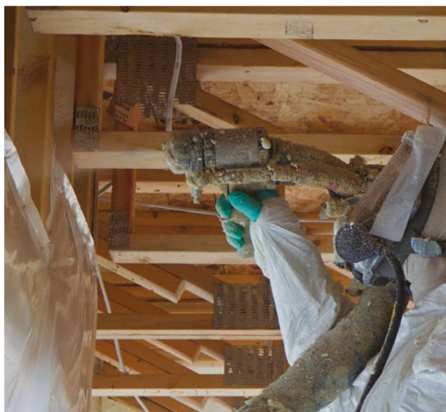
ЗАПОЛНЕНИЕ СТЫКОВ И ПУСТОТ
