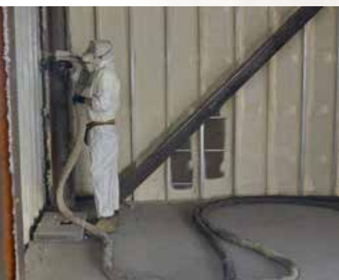
工业及商业建筑墙体
