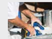
2) Retire la bomba antigua del rociador
