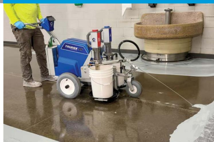
TruMix XT 配备内置电池，让您无需依赖外部电源即可随处进行混合操作。在电力供应受限或不稳定的作业现场，该系统单次充电可完成高达 950 升的物料输送，堪称理想解决方案。您甚至可将物料直接输送至地面，配合快固型材料实现最长可作业时间。
