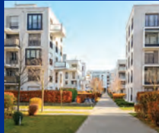
유지보수 및 리모델링
