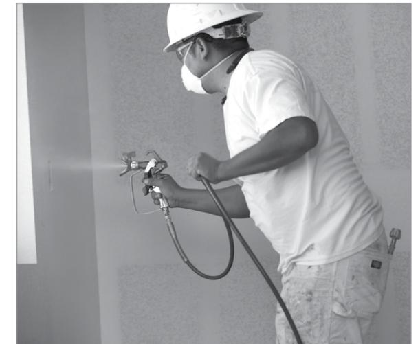
Disminuya la presión tanto como pueda mientras aún está pulverizando un buen patrón de pulverización para reducir el desgaste de su boquilla y bomba. Reducir la presión también ahorra pintura al disminuir la sobrepulverización.
