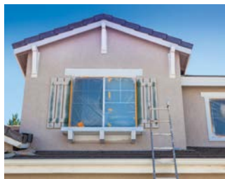
ELEMENTI ESTERNI IN LEGNO
