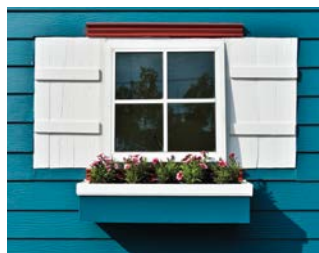
НЕБОЛЬШИЕ РАБОТЫ ПО ВЫСОКОКАЧЕСТВЕННОЙ ОКРАСКЕ
