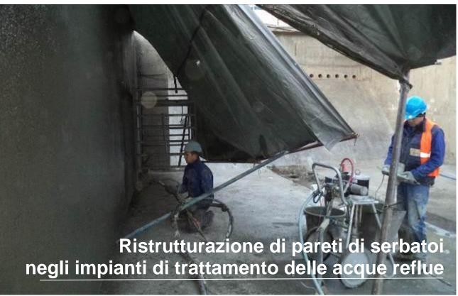
La ristrutturazione di serbatoi di contenimento secondari presso l'impianto di trattamento delle acque reflue a Tomaszów Mazowiecki, in Polonia, è stata assegnata a un appaltatore. Il vecchio calcestruzzo e la protezione di superficie dovevano essere ristrutturati a causa del deterioramento dovuto alle acque reflue. La superficie da ristrutturare era di 2000 m² e il lavoro è stato effettuato in tre fasi.
