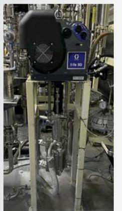
La formación de hielo nunca ocurre en bombas eléctricas como la E-Flo DCi. Esto significa que los operadores de la sala de mezcla de pintura y el personal de mantenimiento no tienen que preocuparse por la contaminación o los problemas de seguridad provocados por la congelación del motor neumático.
