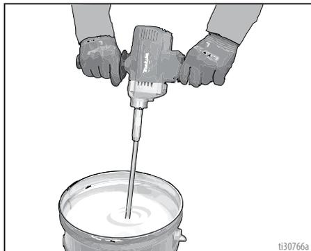
3. 确保混合物在倒入喷涂机漏斗前，所有干粉块已完全绞碎混合。
